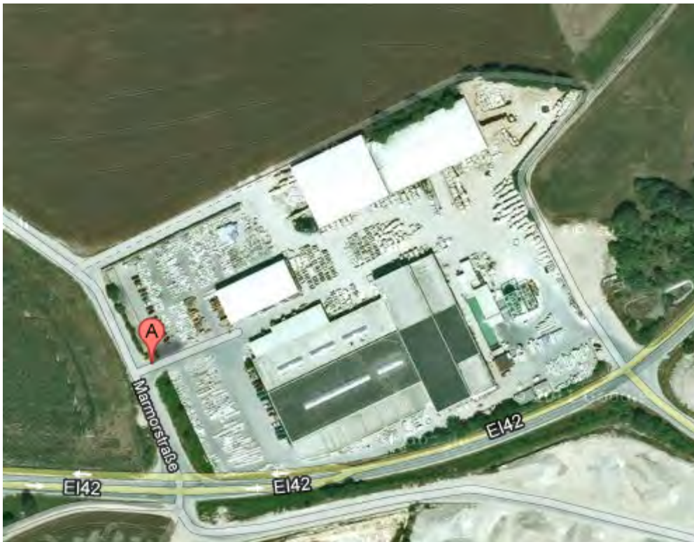
Abbildung 4-2: Luftbild Werk Petersbuch (vor der Erweiterung) (Quelle: google maps)
